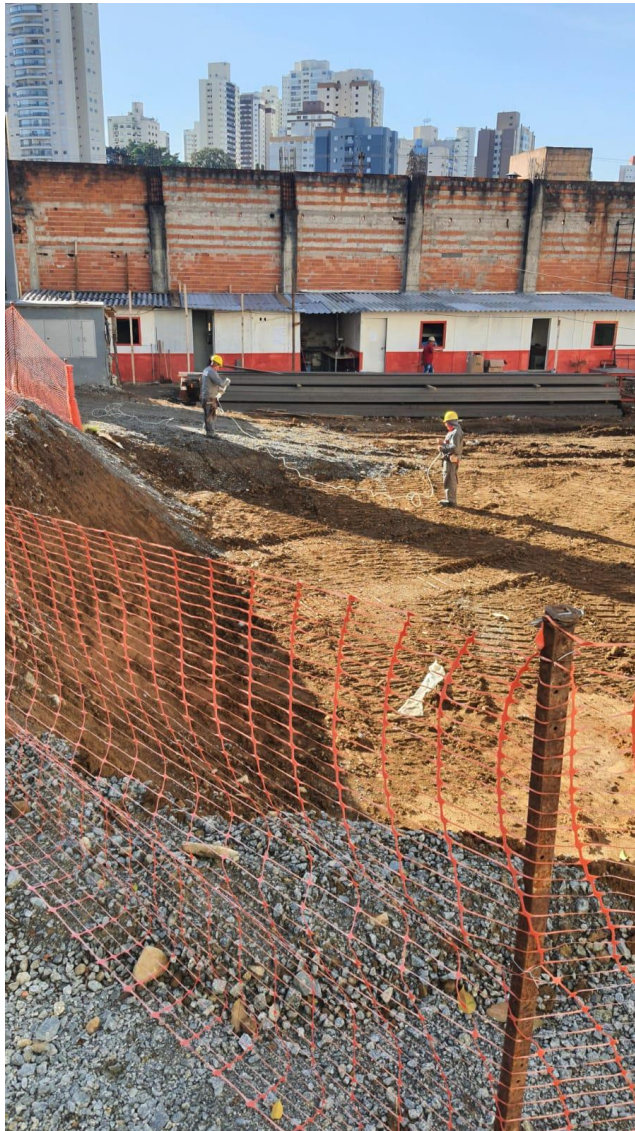
Canteiro e corte terraplanagem,
